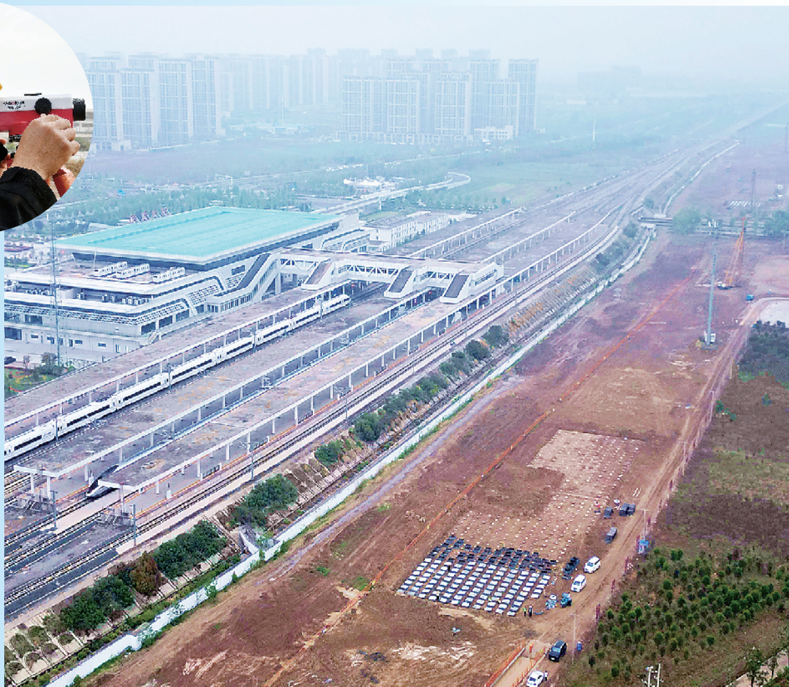
平漯周高铁周口东站施工现场。
