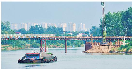
7月2日,作为沙颍河周口至省界航道提升工程的一部分,G329纸店沙颍河大桥开打第一桩。G329纸店沙颍河大桥按照设计主桥采用预应力混凝土变截面连续箱梁,单桥孔双向通航,通航桥孔跨径140米,实际通航净宽为129.5米。
