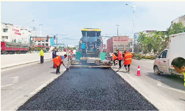
连日来,我市持续出现高温天气,为及时抢修病害公路,给过往车辆和行人提供顺畅的出行环境,淮阳区公路事业发展中心的养护工人各司其职,在不同岗位上经受高温“烤”验。
