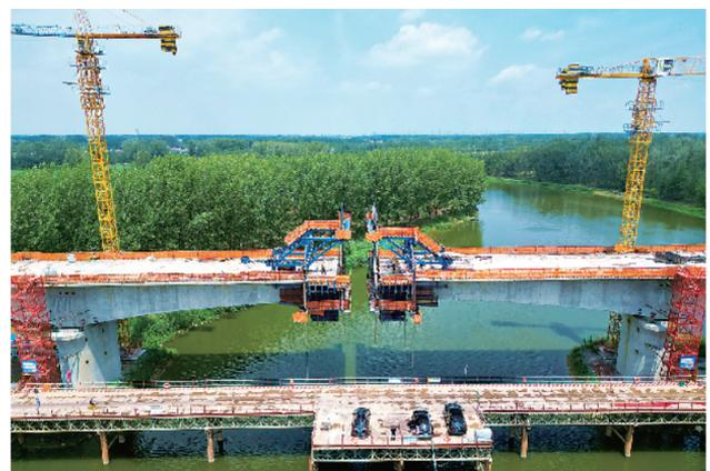
6月30日，中铁七局的工人正在平深周高铁周口段跨颍河大桥上施工。平深周高铁周口段跨颍河大桥是中铁七局在周口境内施工的三条跨河桥梁之一，于2023年动工，桥长416米，预计本月底合龙。
