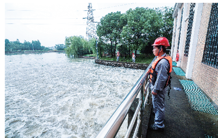
嘉兴市南湖区大桥镇十八里圩区运维人员在夏汛港泵站实地巡查,查看水泵排涝情况。 新华社记者 徐昱 摄
