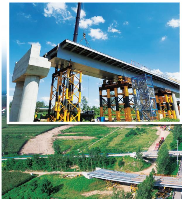
8月29日，中交第一航务工程局有限公司承建的兰沈高速兰考至太康段四标符草楼枢纽互通E匝道边跨箱梁顺利合龙。
